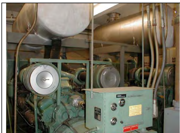
מסגרות מתכת לצורך תפיסה של ציודים וקווי מערכות. בית חולים קייסר פרמנטה - פנורמה סיטי. (מרץ 2004)
